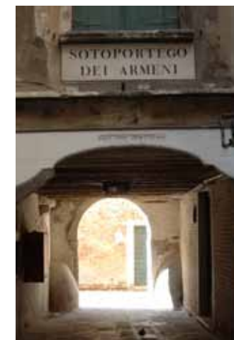
Scorcio del Sotoportego dei Armeni, all'imbocco dell'omonima calle
